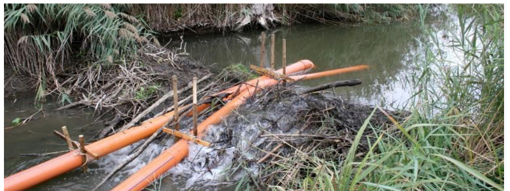
Das Einlegen von Drainagen in Biberbauten ist ein probates Mittel zur Konfliktminderung und zum Schutz vor Vernässung durch Dämme (Foto: Sabine Lerch).
